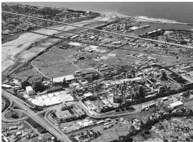
広大な敷地の明星セメント・糸魚川工場
