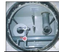
ばっ気循環処理槽
