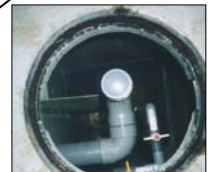
SS沈殿貯留槽第1室
