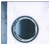
SS沈殿貯留槽 第2室
