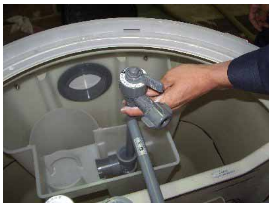
ユニオン緩め送気管を外す
