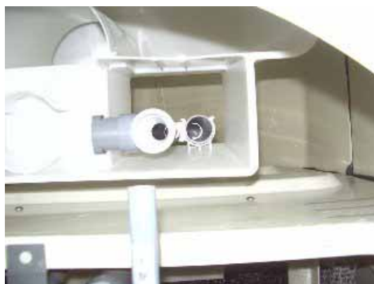
送気管を外した状態
