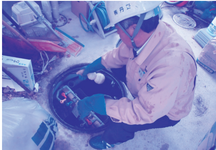
消泡剤の散布。点検前に確認された泡が消えた。
